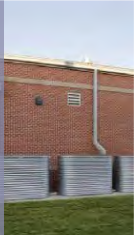
CISTERN | RAIN TANK | CISTERNA | TANQUE DE LLUVIA
